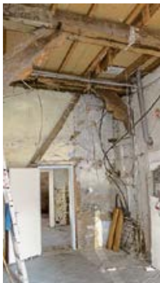
Wenn diese Balken erzählen könnten: Blick ins Innere während des Umbaus
